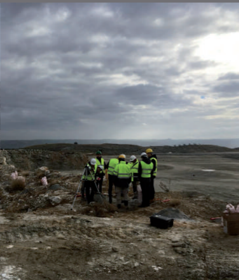
Ingeniería de voladuras.
